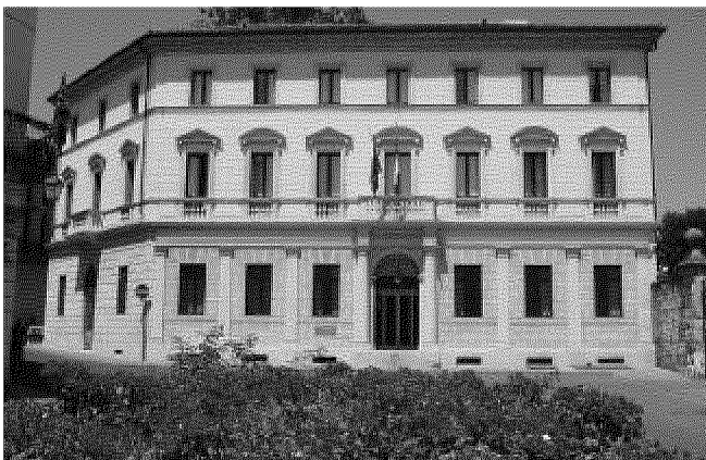
La sede di Confindustria in piazza Castello
